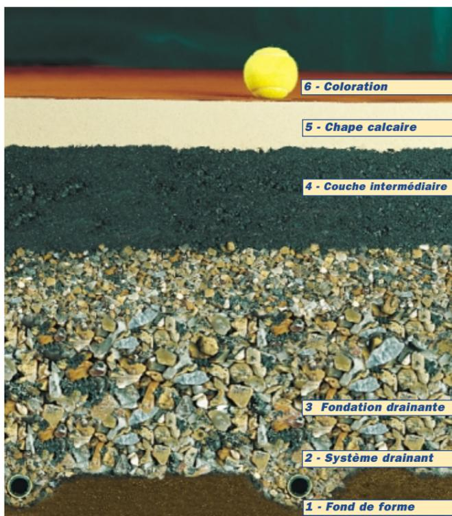
stocker l'eau de pluie ou d'arrosage. Lorsqu'il y a trop d'eau, le surplus s'évacue dans la fondation, et quand le craon s'assèche, l'eau retenue dans le mâchefer remonte par évaporation permettant ainsi une bonne humidification de la couche supérieure.
